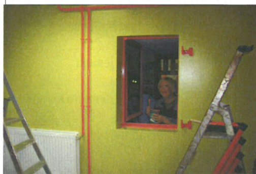
La fenêtre et le volet de l'ancienne salle de sieste ont subi le même sort
